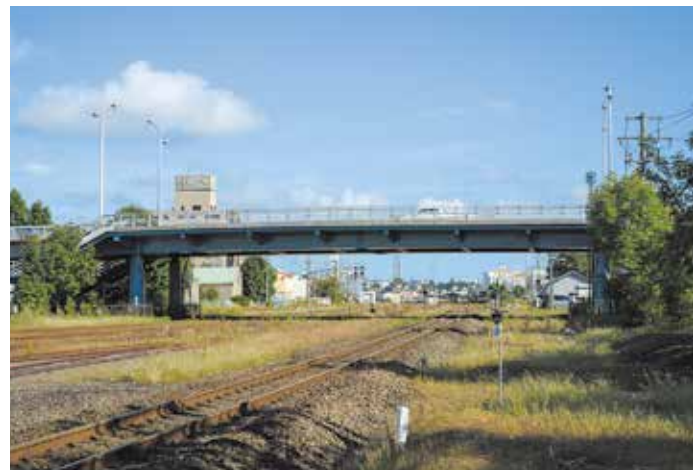
北中跨線橋。鉄道高架事業が実現すると跨線橋以外にも線路を越えられる
